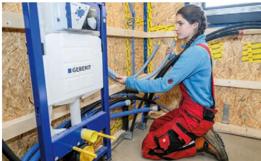
➤ Auf der Baustelle verlegt die Lernende die Wasserleitungen zu den einzelnen Stockwerken.
