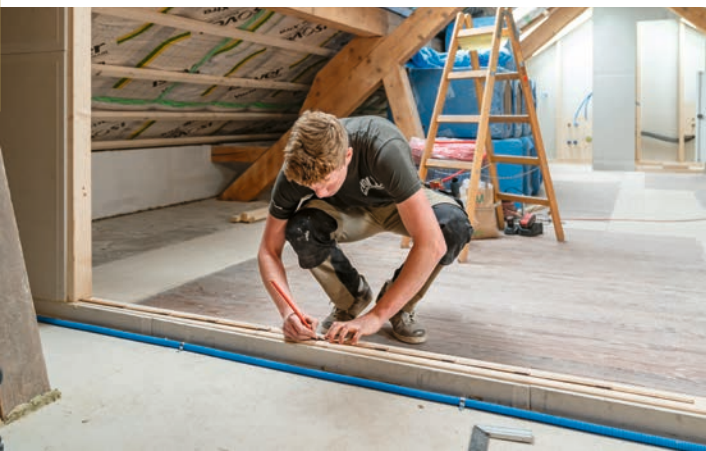
^ Vermessen Holzbauelemente müssen genau passen, dicht sein und tragende Funktionen erfüllen. Das gelingt nur, wenn Zimmerleute die Räume genau ausmessen.
