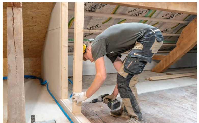
^ Innenausbau Zimmerleute haben nicht nur auf Dächern zu tun, sondern arbeiten auch in Innenräumen und ziehen zum Beispiel Zwischenwände ein.
