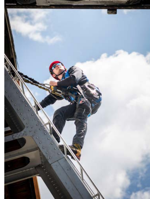
^ Einsatz in schwindelnder Höhe: Nah am Seil hat Marcel einen guten Blick auf den Zustand der Rollen und des Seils.
