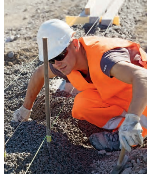
^ Dario Coduri kontrolliert den Verlauf der Richtschnüre.
