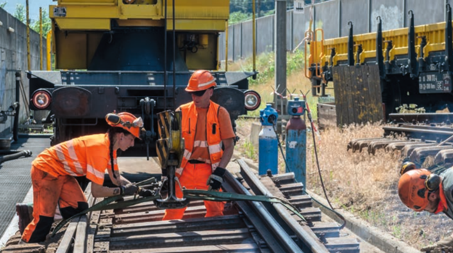
◀ Mirjam e i suoi colleghi fissano i pesanti pezzi di binario alla gru su rotaia.
